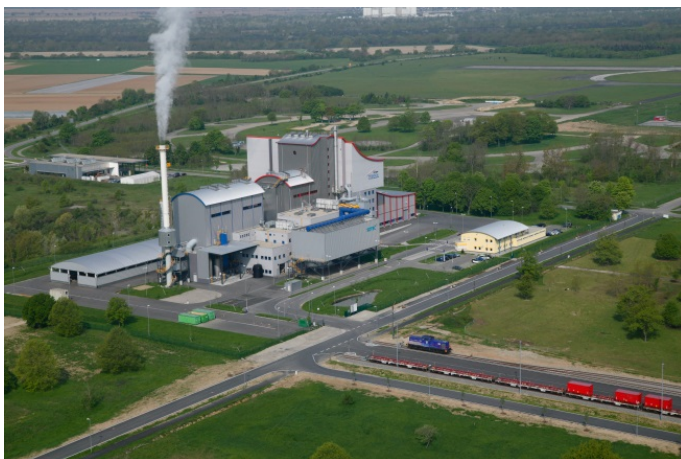
Abbildung 8-1 Luftbild TREA mit Gleisanlage
